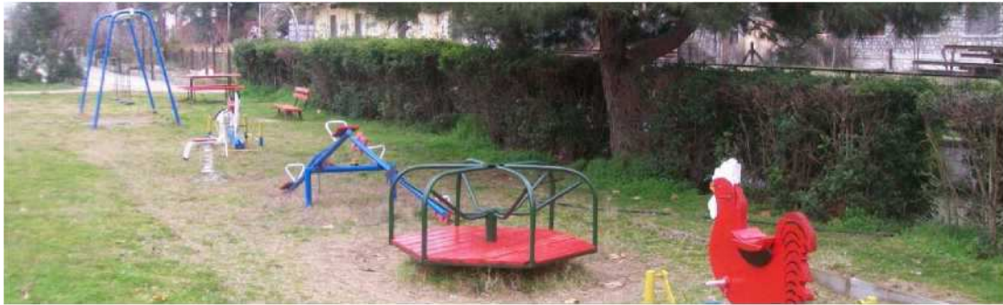
Φωτ. 4: Έλλειψη δαπέδων ασφαλείας
