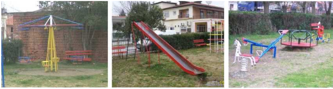
Φωτ. 4: Έλλειψη δαπέδων ασφαλείας
